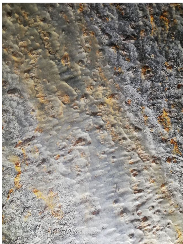
Figura 9: Condotta 3 – Dettaglio di un tratto di superficie laterale senza verniciatura .
